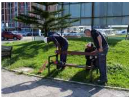
Reparações de bancos de jardim
