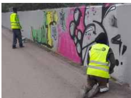
Remoção de graffitis não autorizados
