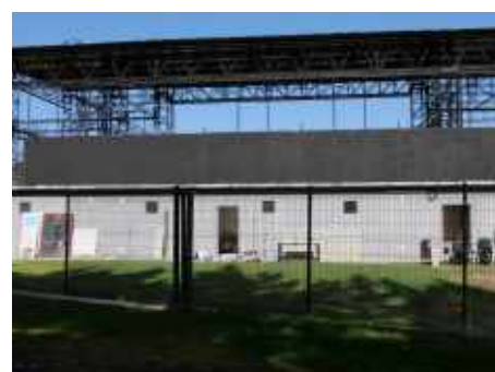
Palco Carlos Paredes foi alvo de obras de manutenção e pintura
