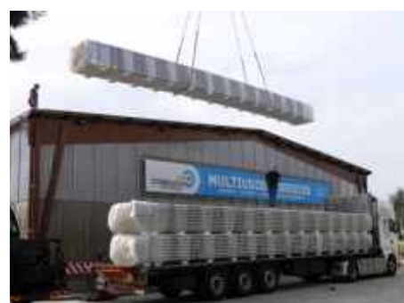
Substituição da cobertura do pavilhão multiusos
